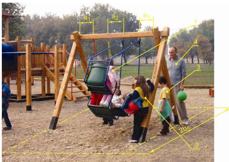
Slika 1: Primer nepoštovanja sigurnosne zone oko dečijeg mobilijara u slučaju ljuljaške sa jednom klasičnom i jednom dvosedom ljuljaškom)
